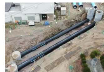
写真3 上流側接続~放水路接続 (4月9日 埋設配管の設置状況)
