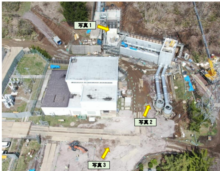
[工事箇所全景(2024年4月18日撮影)]
