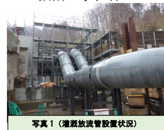
写真1(灌漑放流管設置状況)
