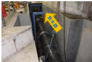
減圧バルブ設置予定箇所ダミー管組立て状況
