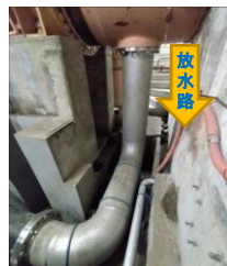
水圧鉄管分岐点配管組立て状況
