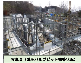
写真2(減圧バルブピット構築状況)
