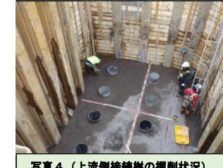
写真4(上流側接続桝の掘削状況)
