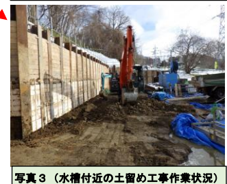
写真3(水槽付近の土留め工事作業状況)
