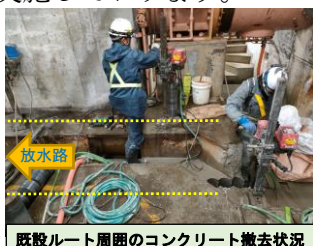
既設ルート周囲のコンクリート撤去状況
