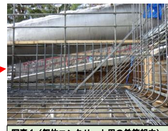
写真1(躯体コンクリート用の鉄筋組立)
