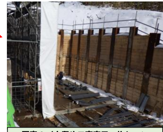
写真2(土留め工事完了・均しコンクリート打設完了)
