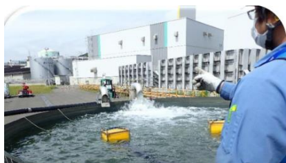
ポンプ運転操作による送水訓練
