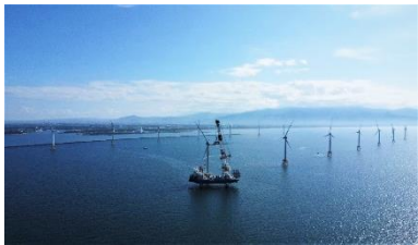
石狩湾の洋上風力発電 (2024年1月運開)
