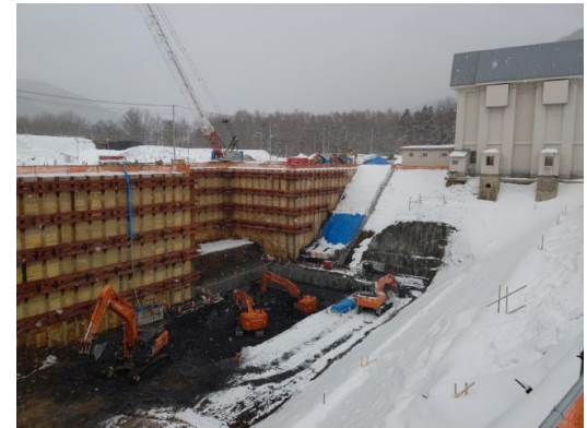
上川発電所リプレース工事の様子
