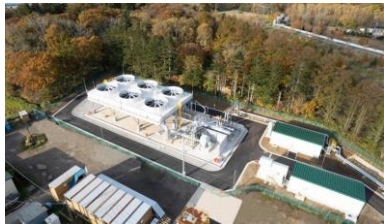
森町の地熱バイナリー発電所 (2023年11月運開)
