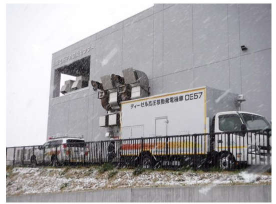
オフサイトセンターへの電源車接続確認訓練
