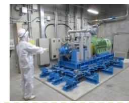
蒸気発生器直接給水用高圧ポンプ
