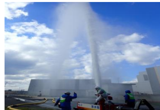
放水砲による放水訓練 (SAT)
