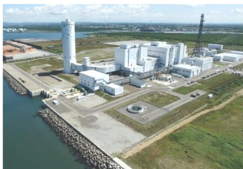
石狩湾新港発電所
