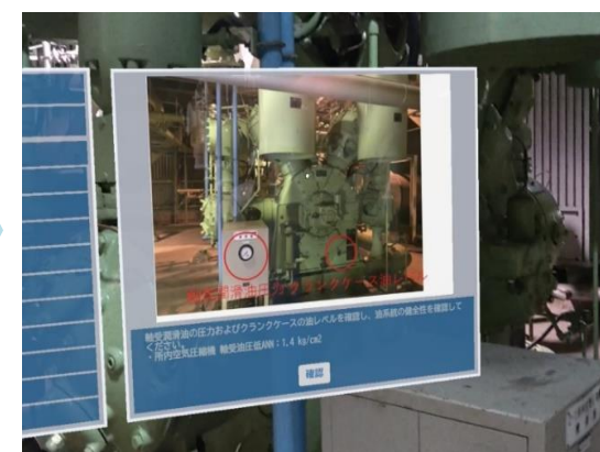
設備に近づくと、自動で確認ポイントや注意事項等のデジタルコンテンツを表示
