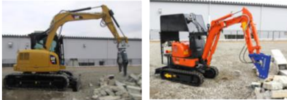
小型・大型無線重機 (屋外の瓦礫等の除去)
