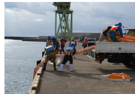
シルトフェンス設置訓練
