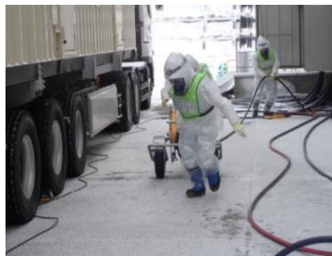
ケーブル敷設訓練
