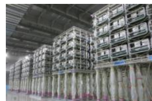
北斗変換所の変換器
