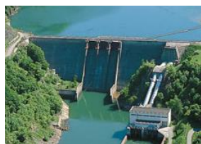
静内発電所(静内ダム)
