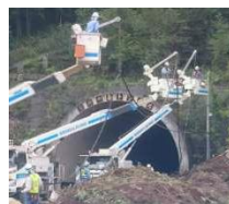
災害時の復旧作業
