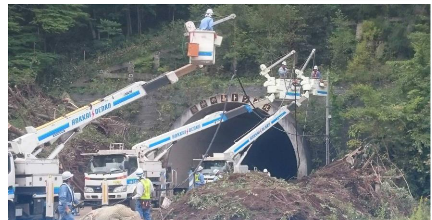
道路啓開箇所での復旧作業(厚真町幌内)
