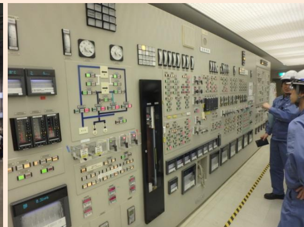
プラント起動・停止研修(保修員[制御]) プラント起動時におけるパラメータ確認
