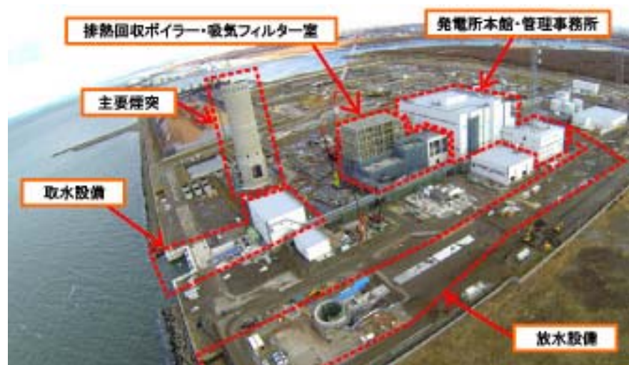
発電所工事エリアの全景
