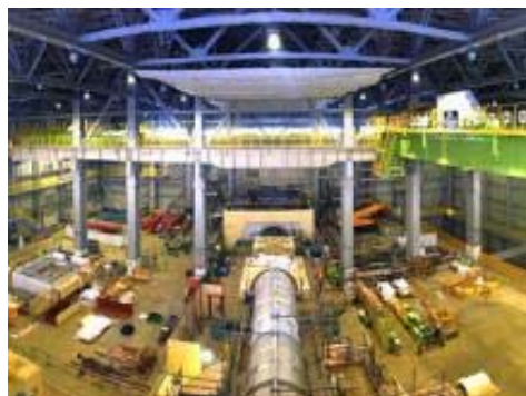
発電所本館内の工事状況
