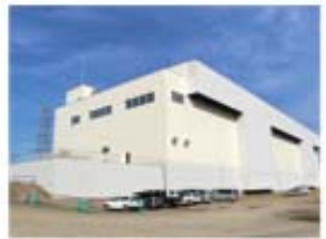
蓄電池建屋外観
