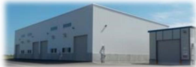
苫小牧リサイクルセンター
