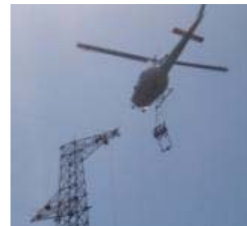
ヘリコプターを用いた送電線工事
