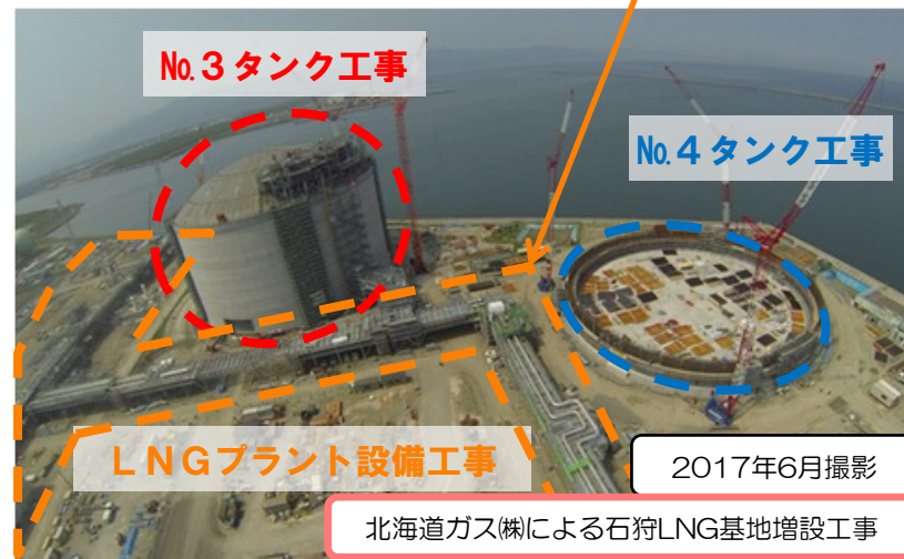
＜石狩LNG基地における増設工事状況＞
