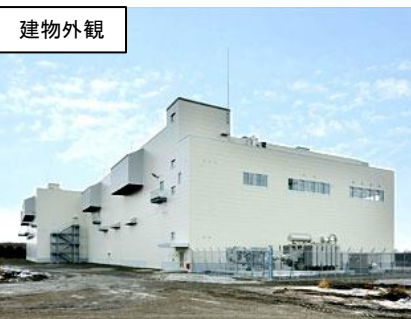
大型蓄電池は2階建ての建屋※に収納 ※設置面積 約5000m 2 (小中学校の体育館の4倍程度)
