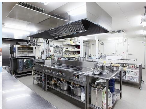
エネルギーロスが少ない IH調理器などを導入した 電化厨房
