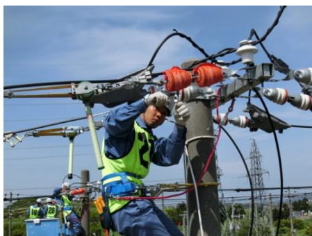
模擬柱を用いた高圧線新設訓練
