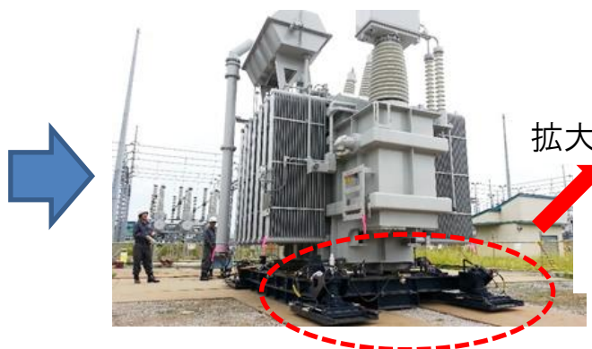
新工法：重量物移載装置による移動
