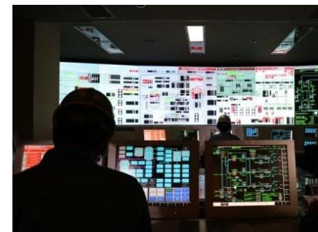
泊発電所の運転訓練シミュレータを使用した事故時操作訓練
