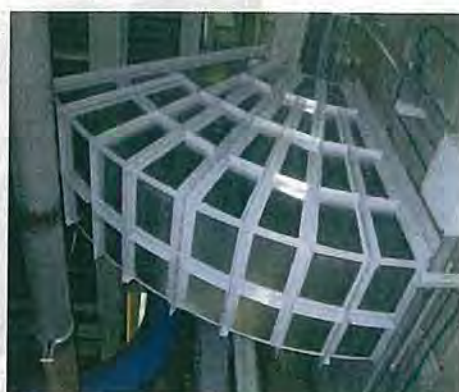
写真 2-7 ドライエリアにおける排気管 写真 2-8 建屋内におけるダクトの浸水対策の浸水対策
