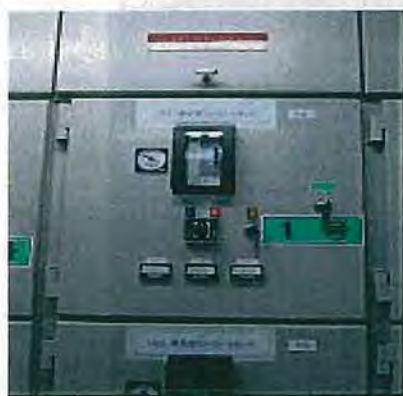
写真 3-3 バッテリ負荷の操作スイッチ
