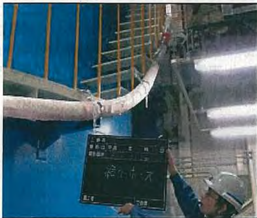
写真 3-36 屋内給水ホース敷設状態
