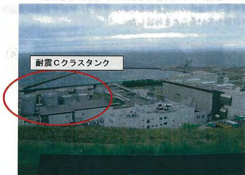
写真1-6 耐震Cクラスのタンク設置状況
