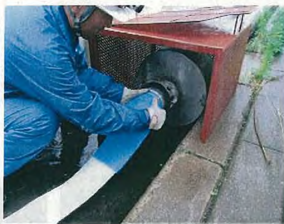
写真 3-30 恒設給水ラインとの接合部
