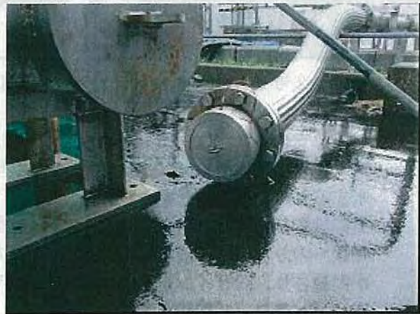
写真 3-34 バックフィル配管から分水器への接合部
