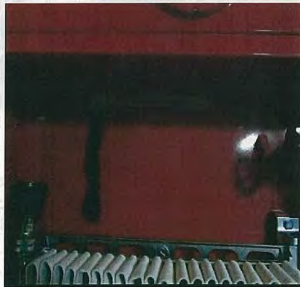
写真 3-39 消火栓と消火栓内の給水ホース固定用ロープ
