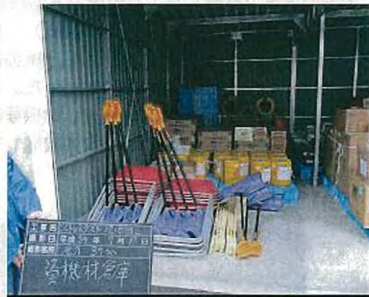
写真 5-5 資材保管庫の保管状況 (2/2)
