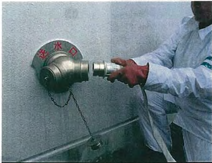
写真 3-38 原子炉補助建屋外壁の送水管
