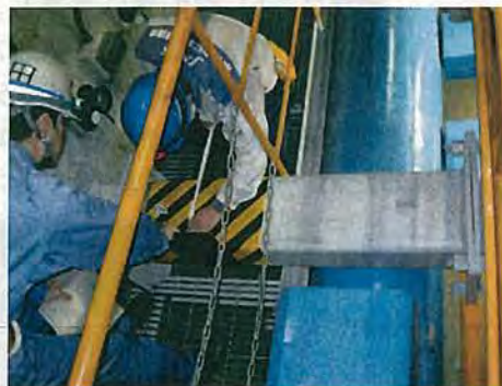
写真 4-4 補助給水系配管のサポート間距離 の測定状況
