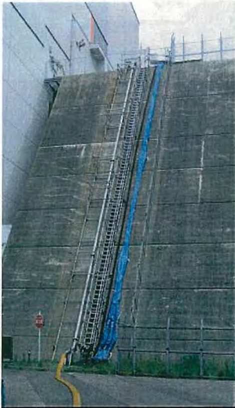
写真 3-33 バックフィル配管
