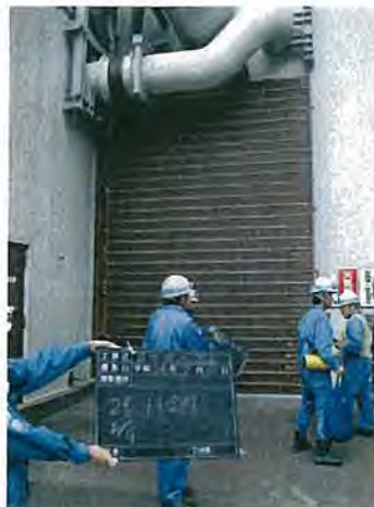
写真2-3 建屋外部扉の防護壁（2号機）
