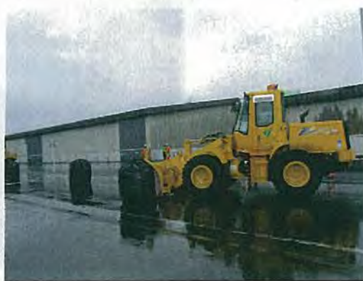
写真 1-9 がれき撤去訓練の状況
