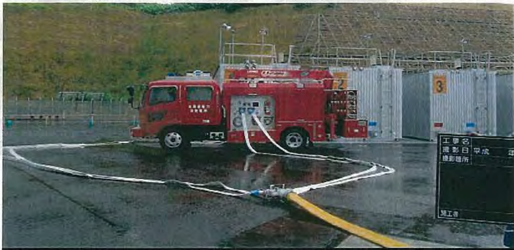
写真 3-24 屋外給水タンクと送水車
