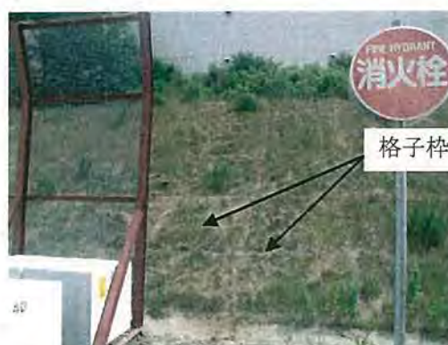
写真 1-4 斜面防護工
