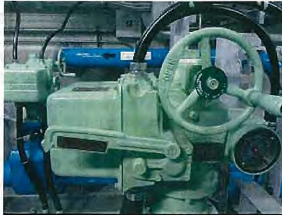
写真 3-9 サーマルバリア冷却系統隔離弁
