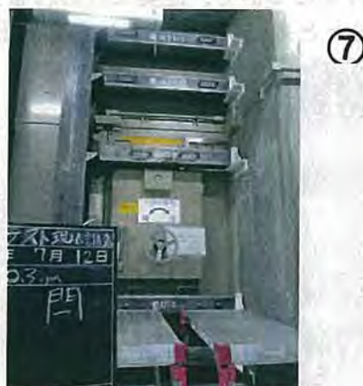
写真 2-6 建屋内部扉 (T/B~R/Bに繋がる扉) の浸水対策
