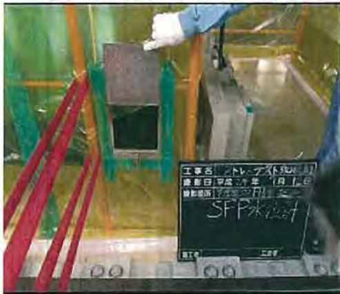
写真 3-40 使用済み燃料ピット水位設置位置 写真 3-41 使用済み燃料ピット水位ゲージ
