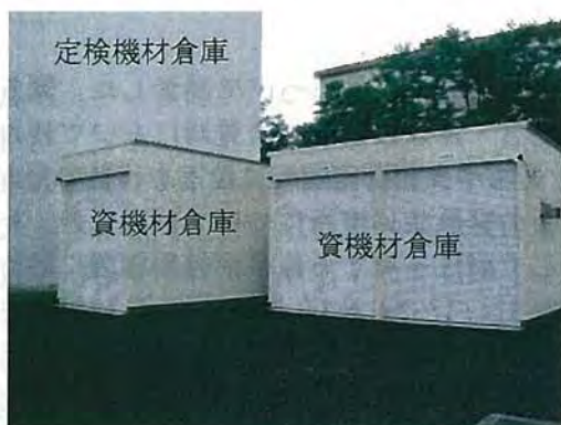
写真1-5 資機材倉庫、定検機材倉庫
