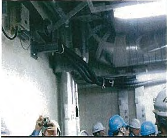
写真 3-16 屋内電源ケーブル侵入口敷設状態
