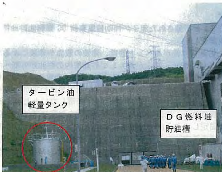
写真 2-12 タービン油軽量タンクとDG燃料油貯油槽
