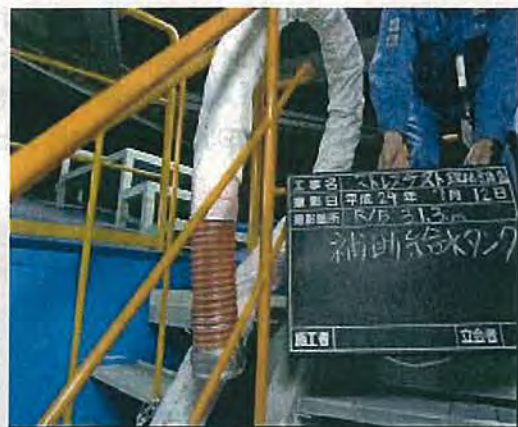
写真 3-37 補助給水タンク給水ホース接続部
