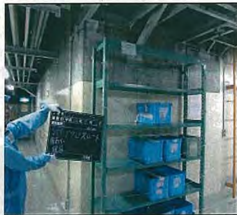
写真 3-43 作業用資機材固縛状況
