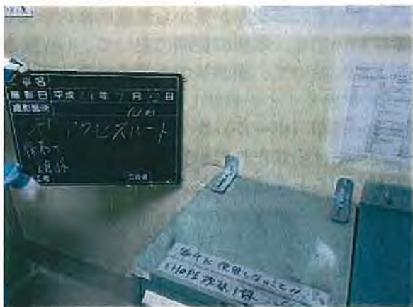
写真 3-42 キャビネット等の壁への固定
