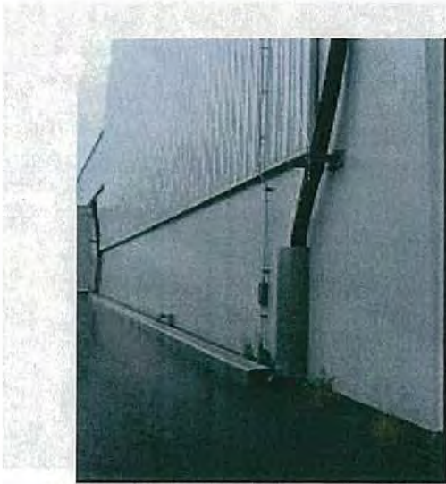
写真 3-14 屋外電源ケーブル敷設状態
