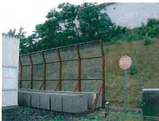
写真 1-3 39m盤周辺斜面
