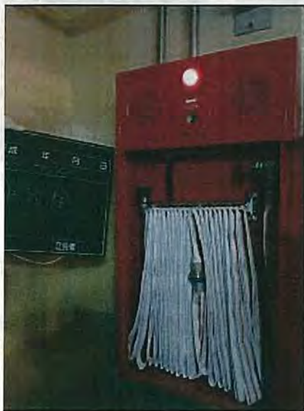
写真 3-39 消火栓と消火栓内の給水ホース固定用ロープ
