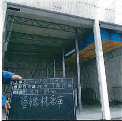
写真 5-1 送水ポンプ車の保管庫
