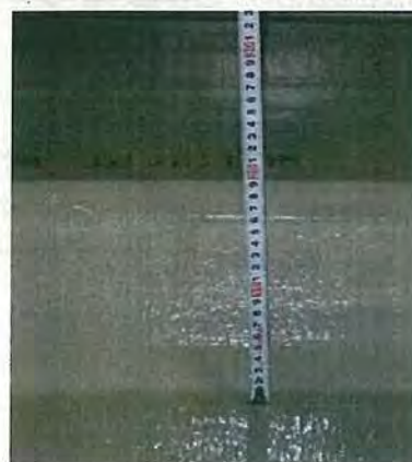
写真 2-16 電気室扉の床～下端距離
