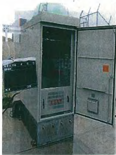
写真 3-11 仮設キュービクル 写真 3-12 仮設キュービクルに接続する電線の埋設部
