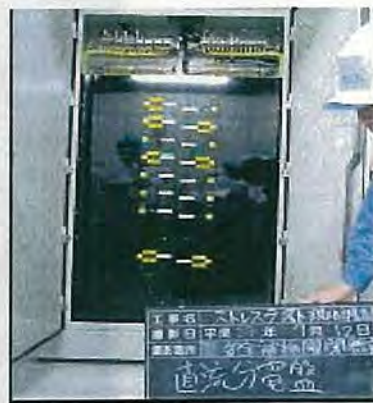
写真 3-3 バッテリ負荷の操作スイッチ
