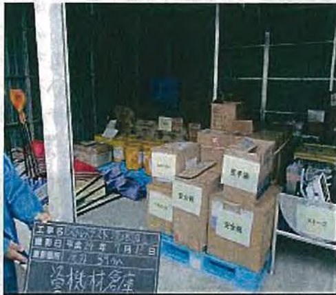
写真 5-5 資材保管庫の保管状況 (1/2)
