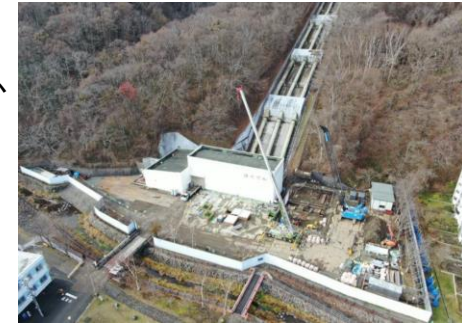
藻岩発電所リプレース工事の様子
