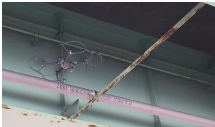
橋梁に施設したケーブル点検
