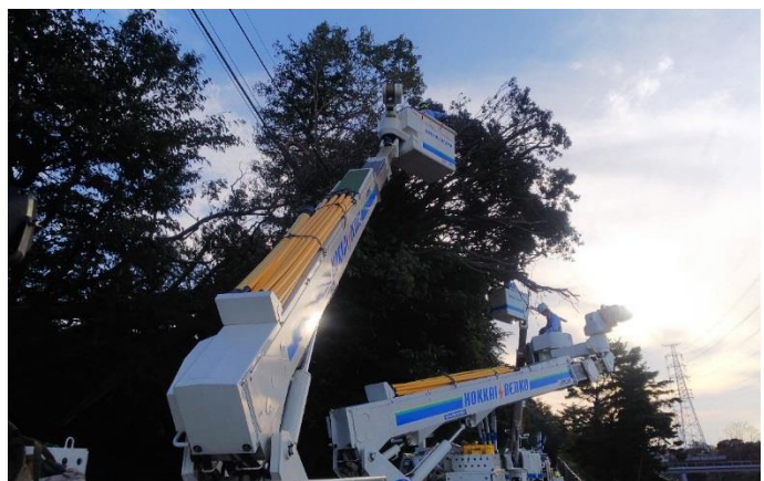
配電設備に倒れた樹木の伐採作業 （千葉県佐倉市）
