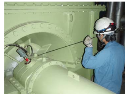
現場でのパトロール状況
