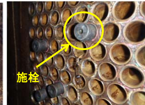
【写真】施栓状況
