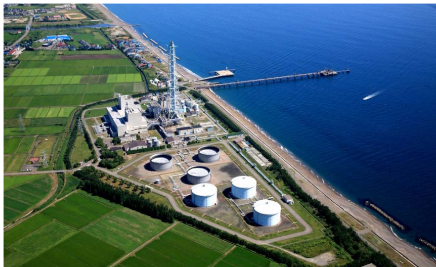
【写真】 知内発電所全景と燃料受入れバース
