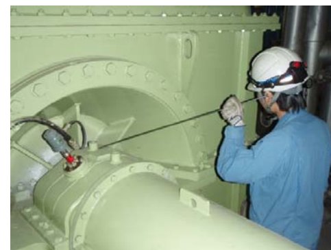
現場でのパトロール状況
