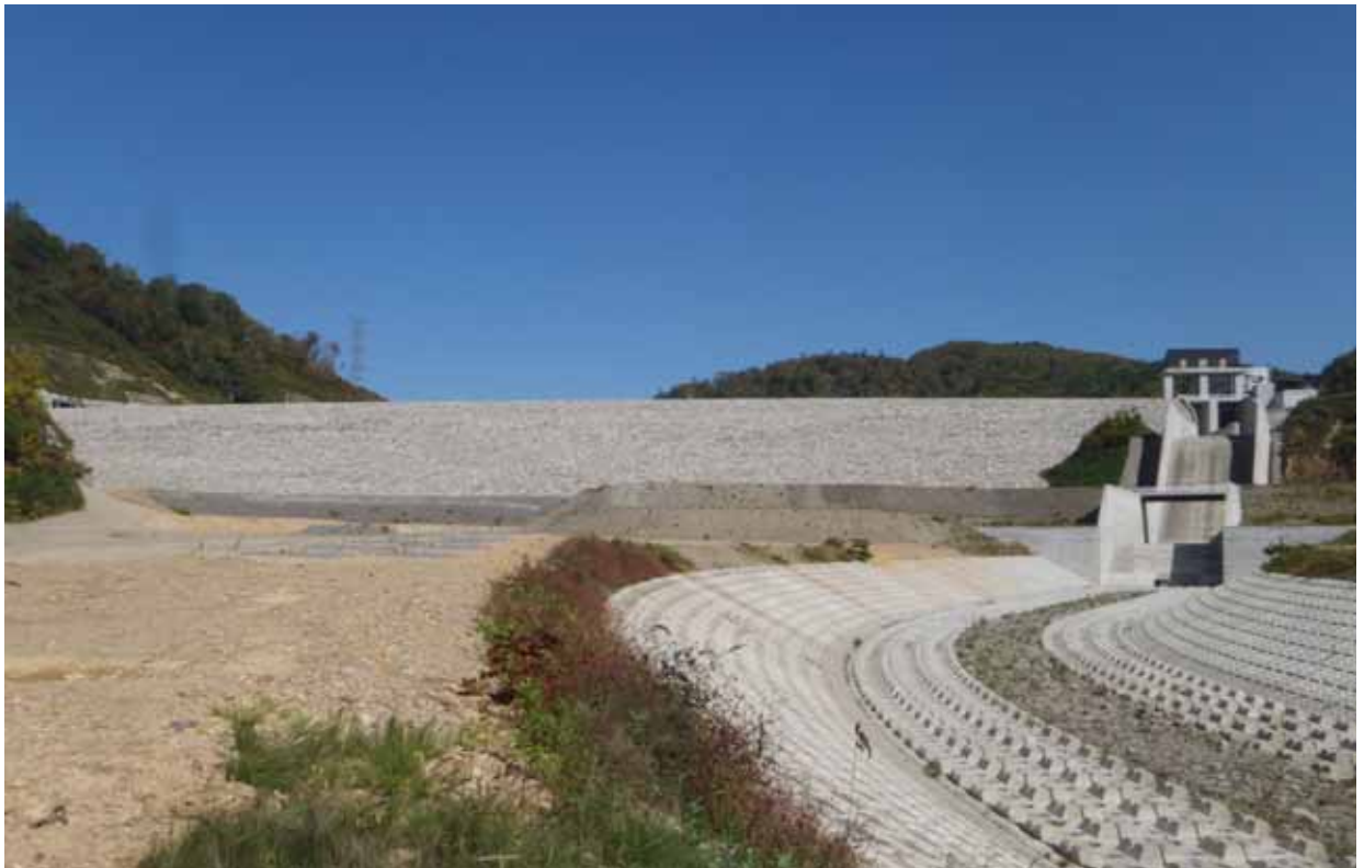
【京極ダム 全景】
