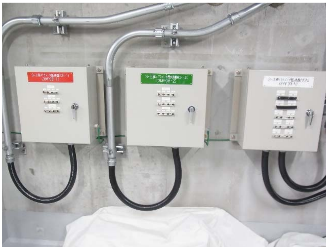
(12) 全交流電源喪失時でも蒸気発生器水位などの監視を可能とする信号計測盤の設置状況
