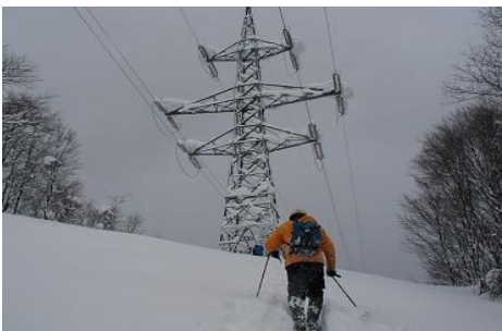
雪上車が入れない場所では人による巡視点検を実施
