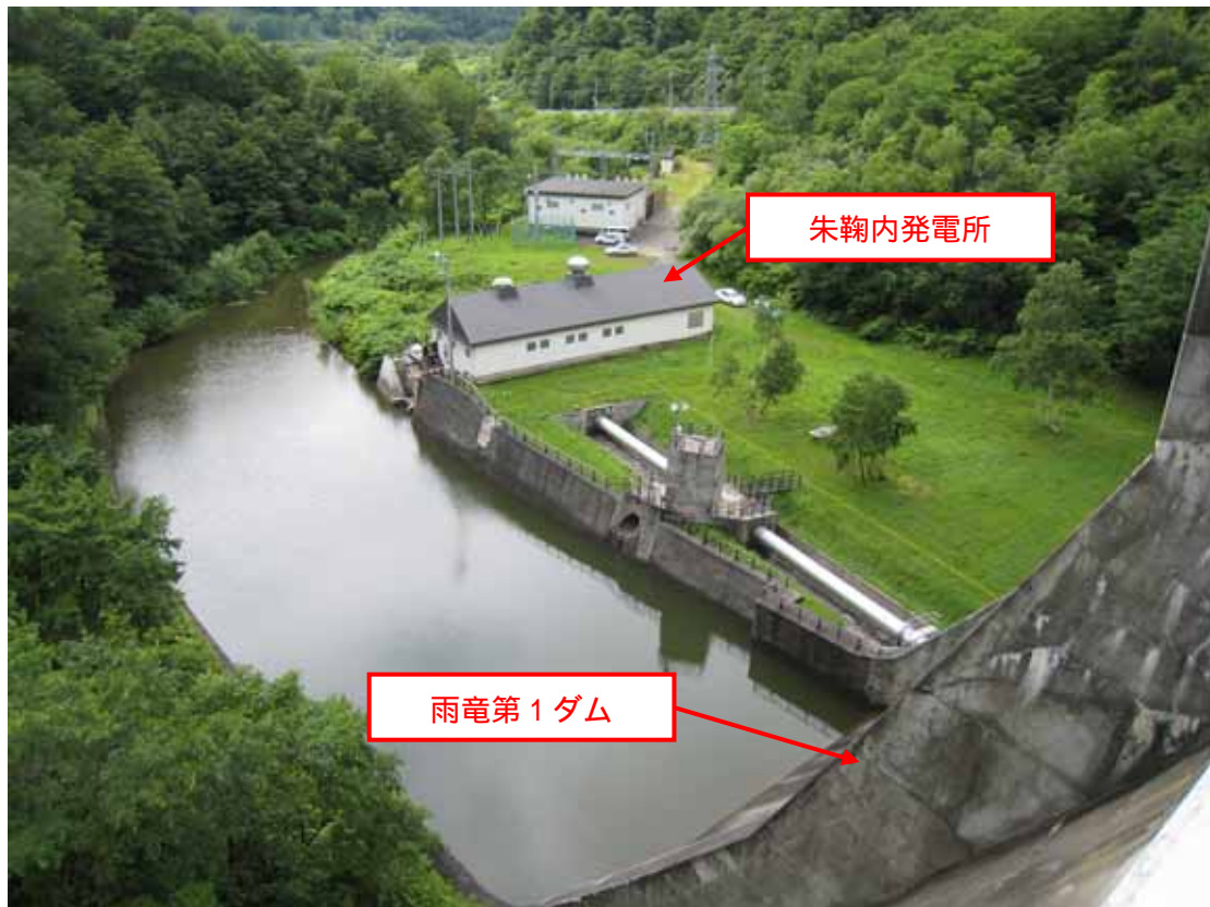
【朱鞠内発電所全景（雨竜第1ダムより発電所を望む）】
