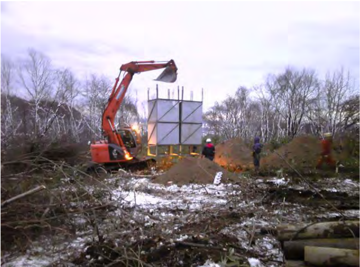
仮鉄柱 (No.29-2) 基礎掘削掘付状況
