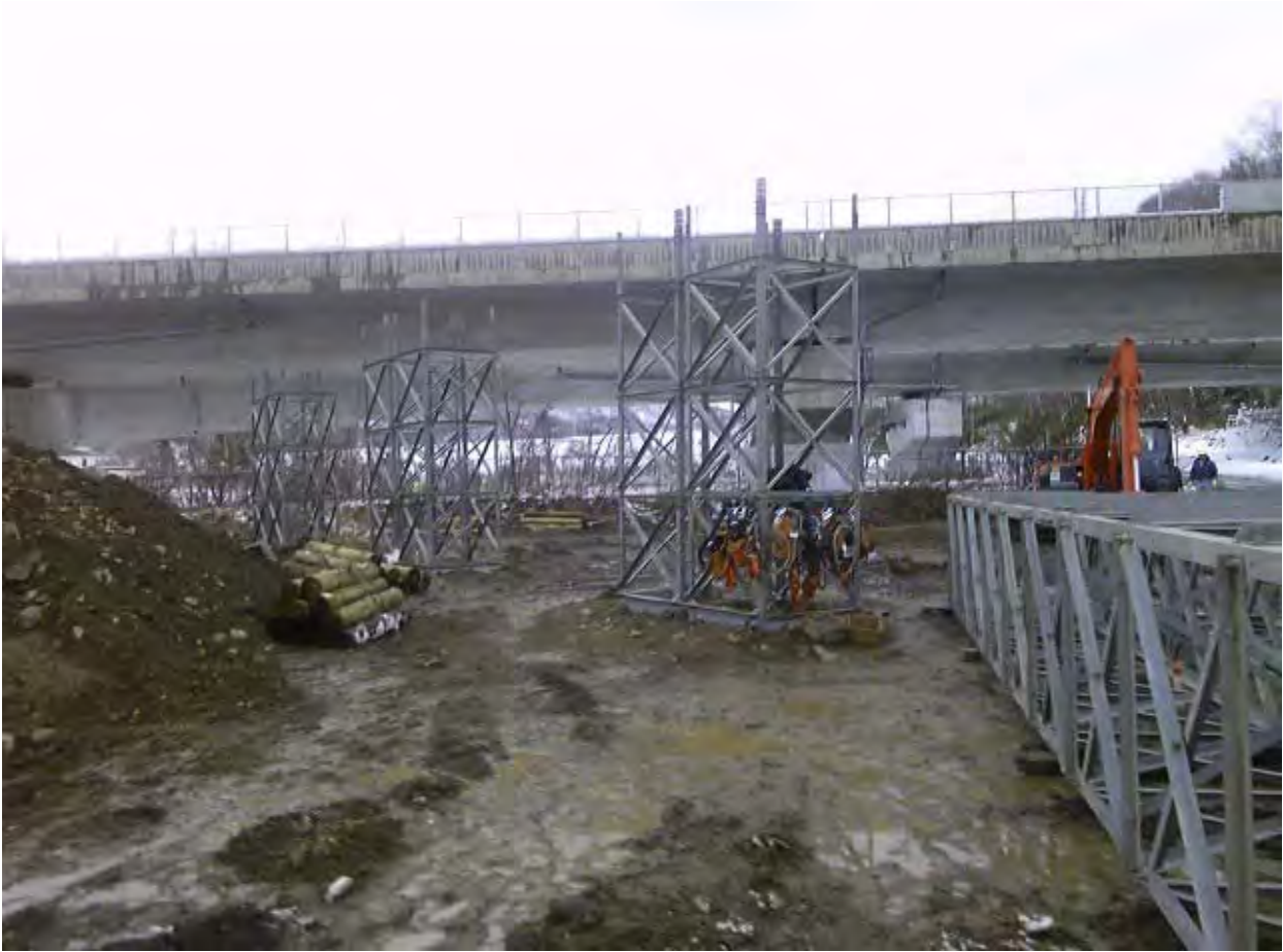
仮鉄柱 (No.29-2) 基礎掘削掘付状況
