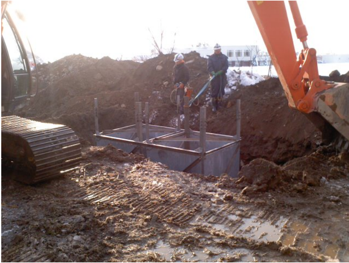
仮鉄柱（No.29-1）基礎工事状況
