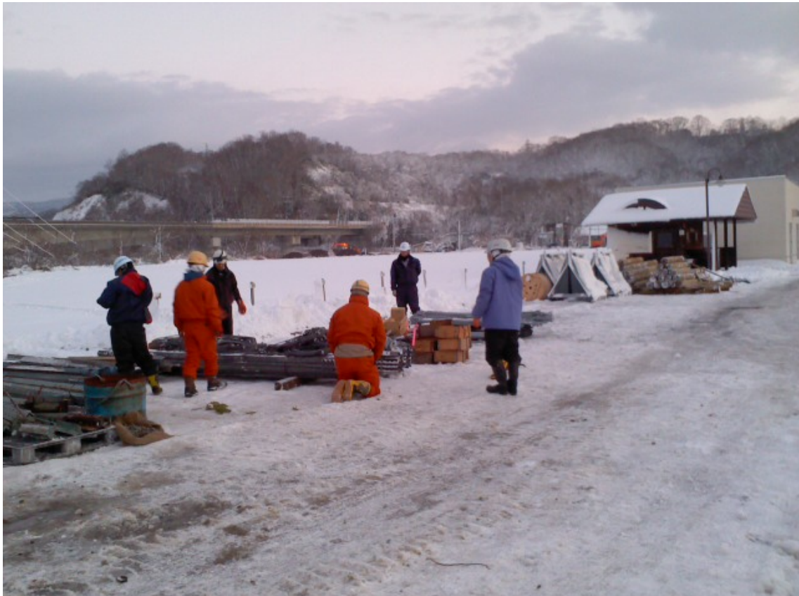
仮鉄柱資材置場
