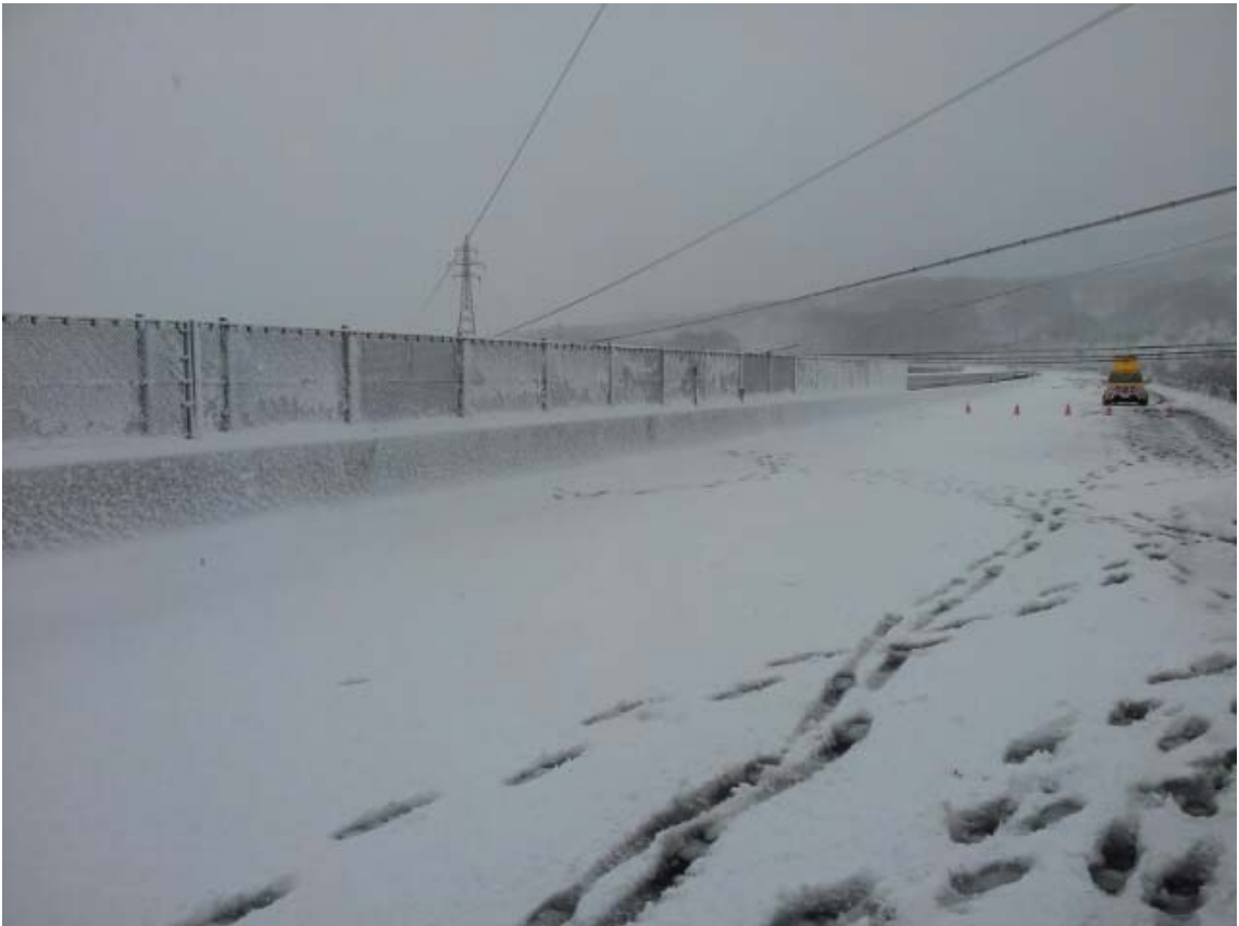
道央自動車道（登別東 IC～登別室蘭 IC） 電線垂下による高速道路閉鎖状況
