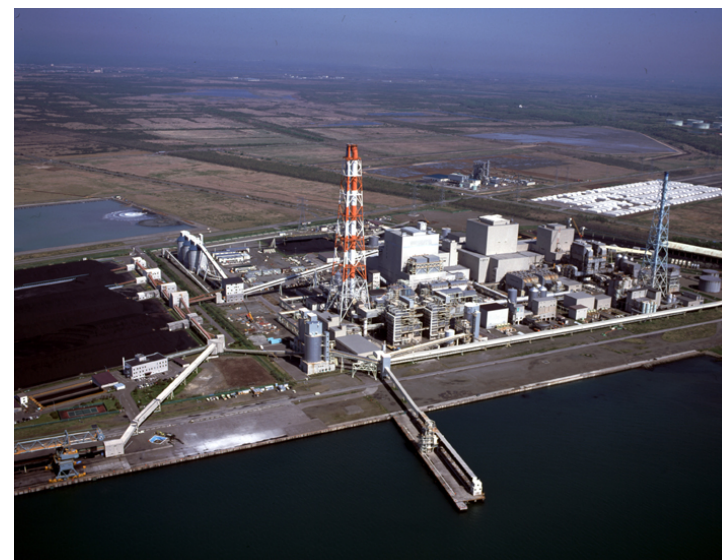
苫東厚真発電所全景
