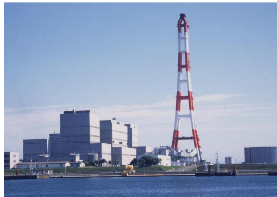
【写真】 苫小牧発電所と苫小牧共同火力発電所
