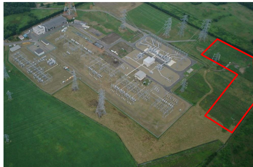
【写真】 南早来変電所への緊急設置電源設置予定位置
