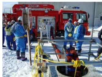
送水ポンプ車
