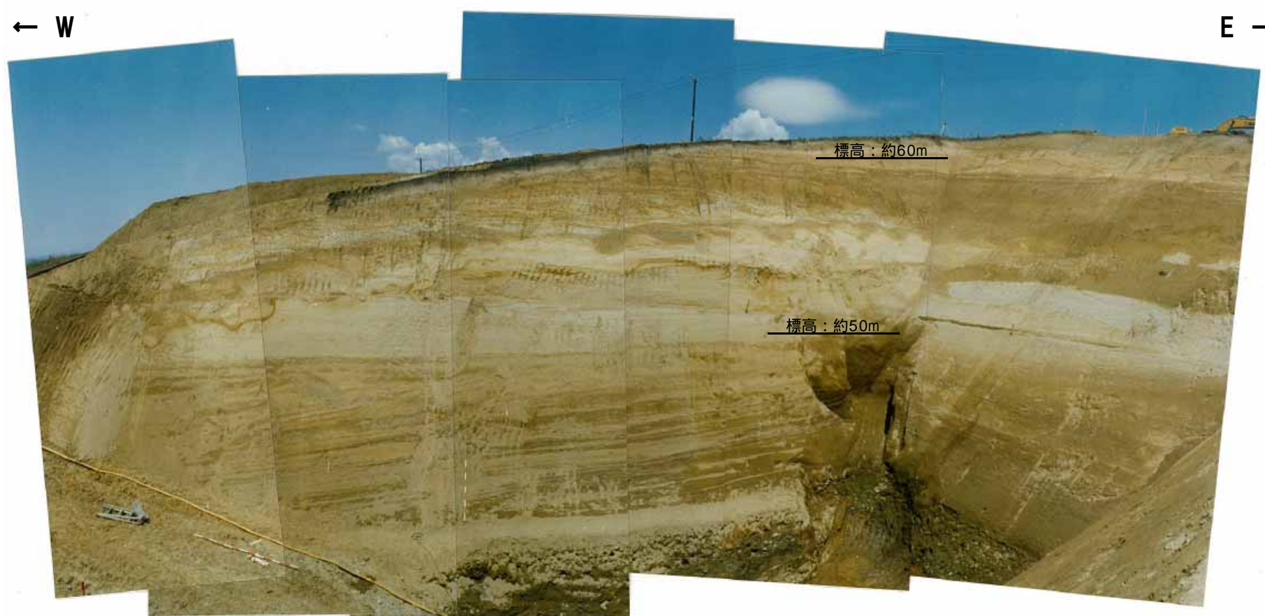
写真1 北側壁面を望む (昭和57年秋頃撮影)
