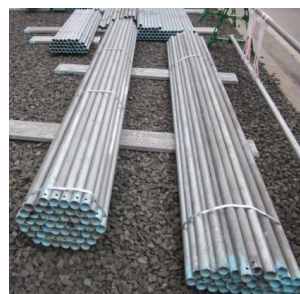
鋼製パイプの飛散防止対策
