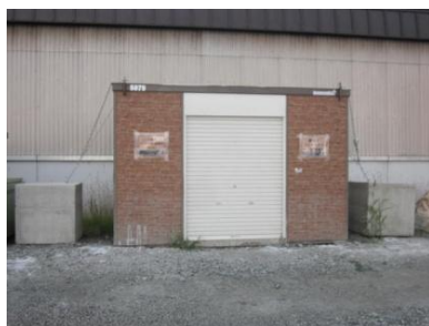
コンテナの飛散防止対策
