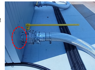
想定破損を考慮する接続配管(管台)
