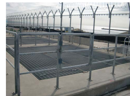
⑨送水ポンプ車取水場所 3号機取水口上部グレーチング
