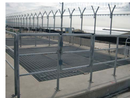
⑧送水ポンプ車取水場所 3号機取水口上部グレーチング
