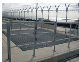
⑧送水ポンプ車取水場所 3号機取水口上部グレーチング
