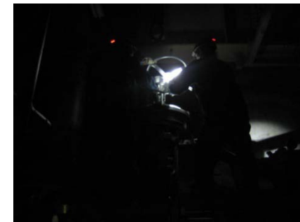
②主蒸気逃がし弁開操作 （照明消灯時）
