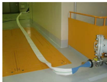
②補助給水ピットへの供給ホース敷設状況
