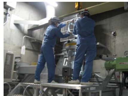
①A-主蒸気逃がし弁開操作 （足場使用）
