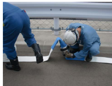
②ホース敷設状況
