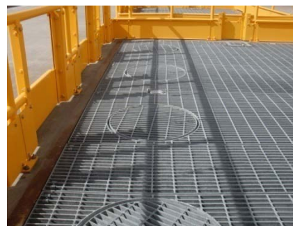
⑦送水ポンプ車取水場所 スクリーン室上部グレーチング
