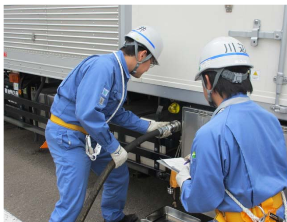
②代替非常用発電機に給油ホースを接続
