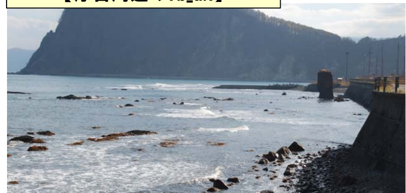
厚苔周辺状況写真 (AT3付近, Vb_alt)
