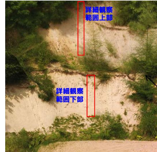
本露頭は、土取り場であったことから、斜面の安定を図るための小段が設けられている。
