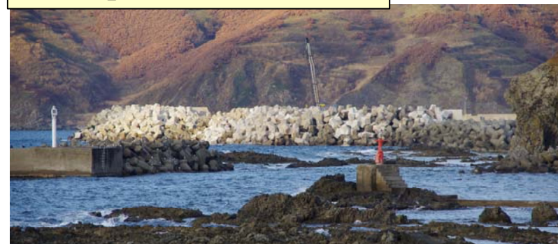
日司周辺状況写真 (HT3付近, Vb)
