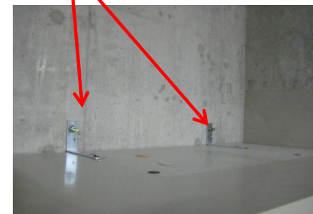
ボルトにより壁に固定
