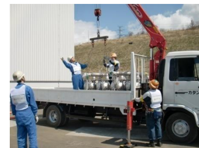
空気作動式ポンプ吊り下 ろし作業
