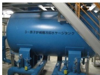
③原子炉補機冷却水サージタンクエリア
