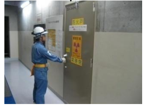
④A-D階段入口扉
