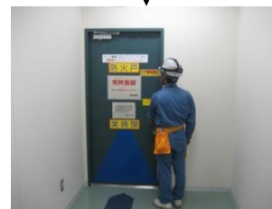
③A-F階段入口扉へ
