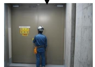
②原子炉建屋から原子炉 補助建屋への境界扉
