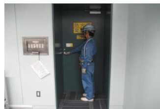
①中央制御室
