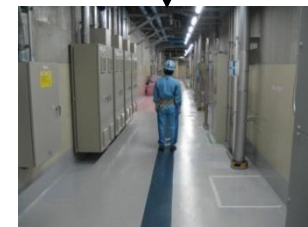
⑥原子炉補助建屋から原子炉 建屋への移動
