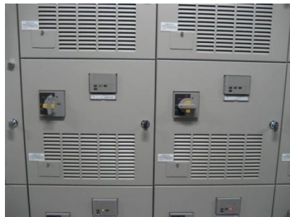
③440Vパワーコントロールセンタ (左側:NFB入状態、右側:NFB切状態)
