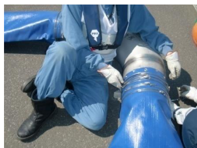
10m盤ホース接続部 (カップラティブではない)
