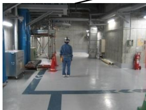
①2インチフレキシブルホース 6.5m×2本 接続箇所 4箇所 (原子炉建屋T. P. 10. 3m)
