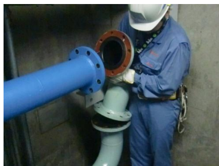
スプールピースの取り付け
