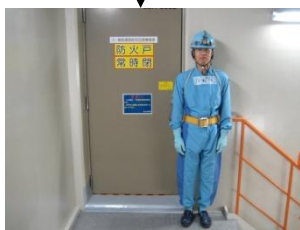
③A-D階段から補助建屋給気空調機械室入口扉へ
