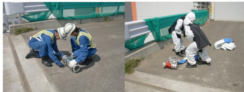
Step No. 10-a-3 ホース敷設(屋外)
