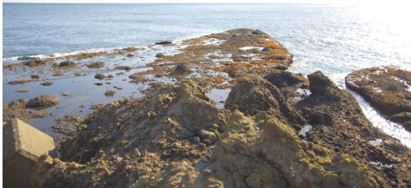
珊内周辺状況写真(SN1付近)
