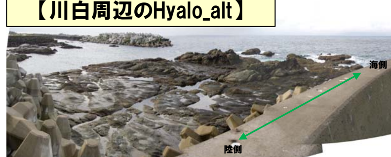
川白周辺状況写真(KS4付近, Hyalo)
