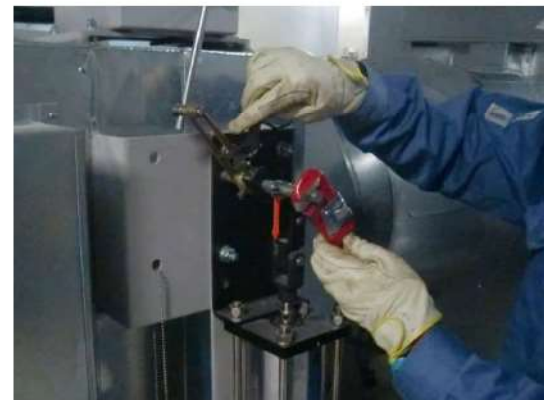
(空気作動ダンパ閉作業イメージ)
