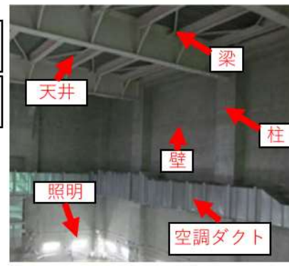
②使用済燃料ピット上部
