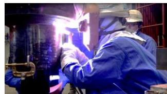
新施工法の様子
